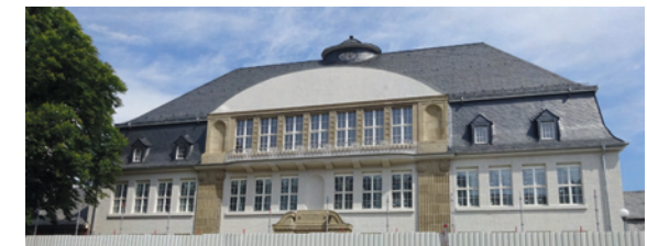
Hauptschule Hederichsfeld, ein Beispiel dafür, was sich aus alten Gebäuden machen lässt.
